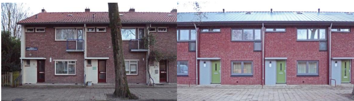
Voor de renovatie
