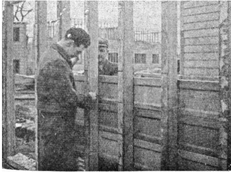
fig. 25. Bevestiging van de wandplaten aan de stijlen met vastgewartelde opeertroden bij het systeem Airey.
