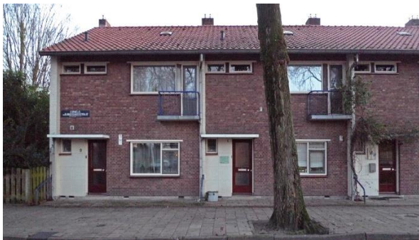
Voor de renovatie
