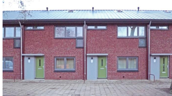
na de renovatie
