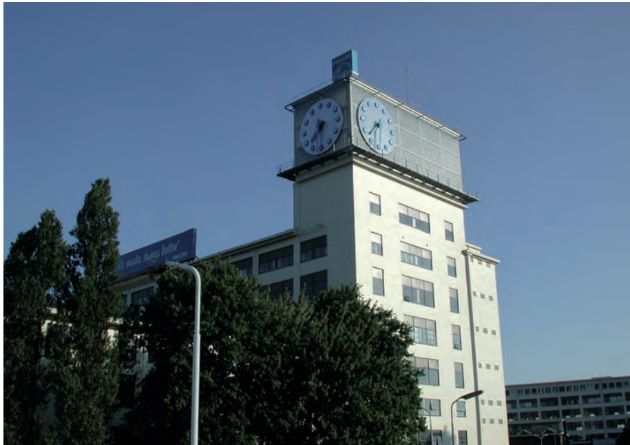
Klokgebouw Strijp S
