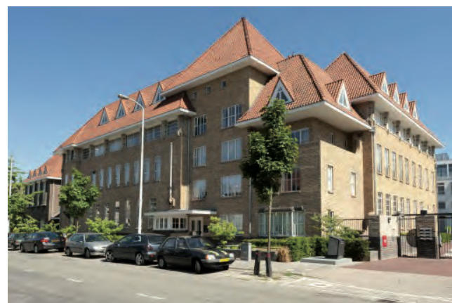
Appartementen in de voormalige huishoudschool St. Martha, ontwerp De Bever Architecten BNA
